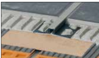
Schlüter®-DILEX-BWB ist ein Bewegungsprofil mit Seitenteilen aus Hart-PVC-Regenerat. Die obere Bewegungszone besteht aus weichem Kunststoff und bildet die 10 mm breite Sichtfläche. (Produktdatenblatt 4.6)
