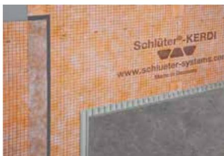
Schlüter-KERDI ist eine Abdichtungsbahn aus Polyethylen, die zur Verankerung im Fliesenkleber beidseitig mit Vliesmaterial versehen ist. Sie eignet sich besonders für Abdichtungen im Verbund mit Fliesenbelägen an Wand und Boden. Schlüter-KERDI-DS ist aufgrund des hohen Wasserdiffusionswiderstands für den Einsatz als Dampfsperre im Verbund mit dem Fliesenbelag geeignet. (Produktdatenblatt 8.1)
