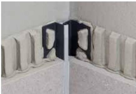
Schlüter-DILEX-EKE ist ein flexibles einteiliges Eckprofil aus Hart-/Weich-Kunststoff für Wandinnenecken oder für den Boden-/Wandanschluss. Das Profil verfügt über eine integrierte Fliesenkammer und kann bei nichtschwimmenden Belagsaufbauten eingesetzt werden. (Produktdatenblatt 4.13)
