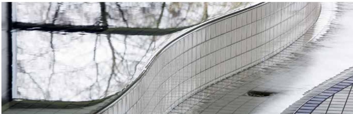
Zum Schutz von Belagsabschlüssen mit gerundeten Randkonturen sind diverse Schlüter-Profile aus Metall mit einer Radiusstanzung erhältlich, die es ermöglicht, das Profil an die Kontur des Belagsrandes anzupassen. Aus produktionstechnischen Gründen können Produkte mit  $L = 1,00$  m nicht mit einer Sonderstanzung versehen werden. Produkte, die mit Radiusstanzung geliefert werden können, erkennen Sie in der Preisliste an folgendem Zeichen:
