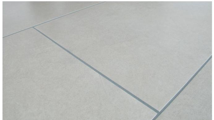
**Abb. 8 – Mit dem PCI Fugenvlies wird sehr wenig Wasser benötigt, um den Fugenmörtel zu glätten; der Lohn: Gleichmäßige, gut gefüllte Fugen**
