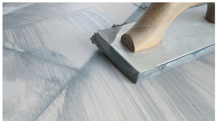
**Abb. 4 – Beim Nachfugen mit der Gummifugscheibe wird ein sehr guter Füllgrad erreicht**
