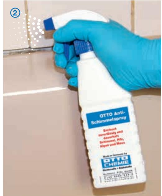
Wichtig ist auch, den Fugenhintergrund und die Flanken von jeglichem Rest zu befreien. Danach muss der betroffene Fugenbereich zwingend mit OTTO Anti-Schimmelspray behandelt werden, um vorhandene Pilzsporen abzutöten. Erst jetzt kann die Fuge neu ausgebildet werden.
